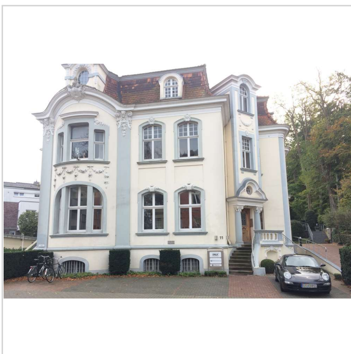
Haus von außen
